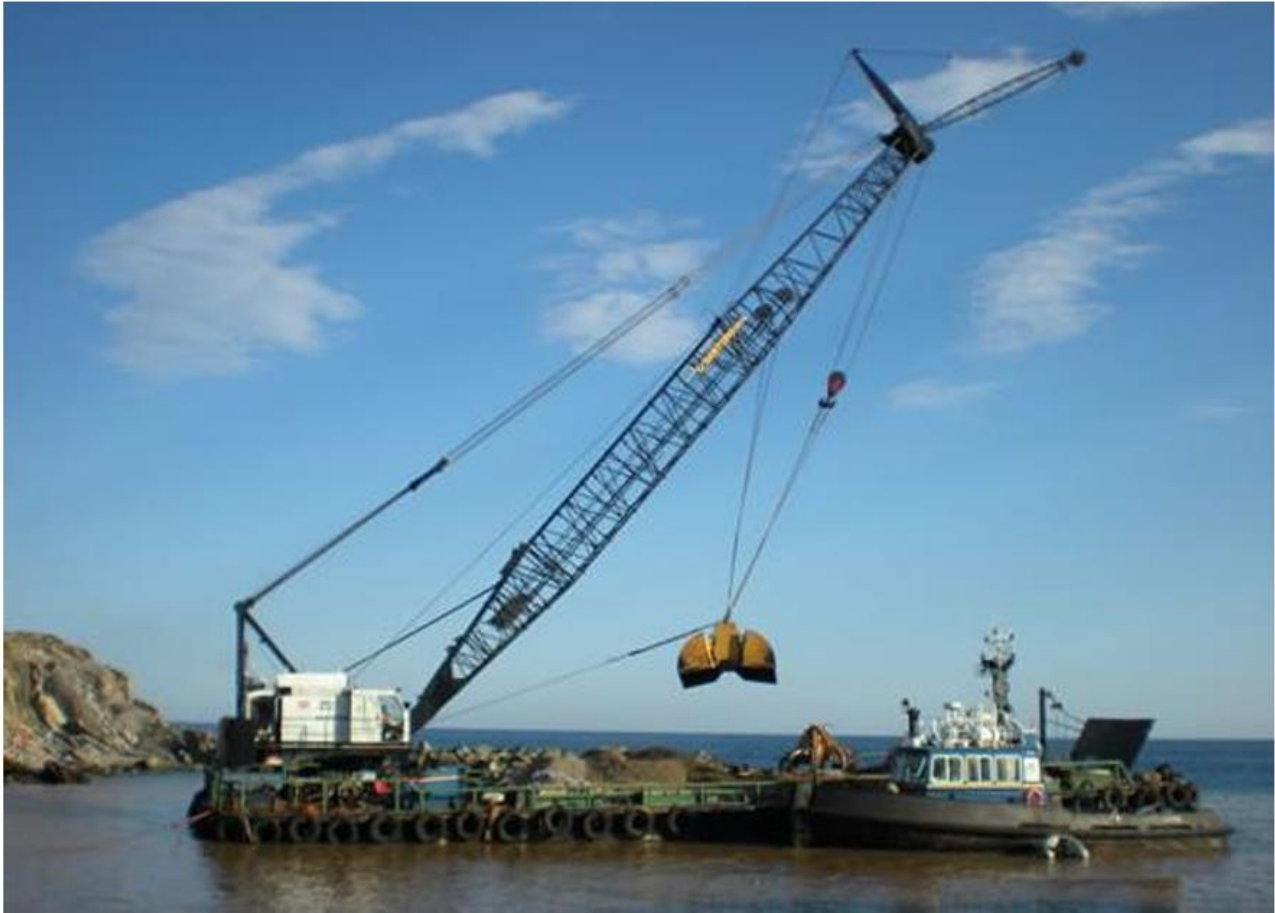
Figura 2. Motopontone equipaggiato con gru per escavo meccanico
